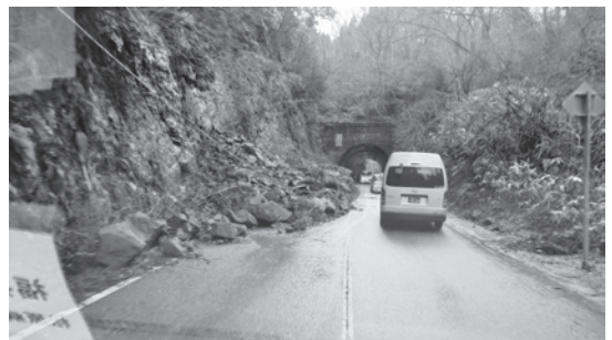
穴水から先の高齢者施設に向う道の がけ崩れ
