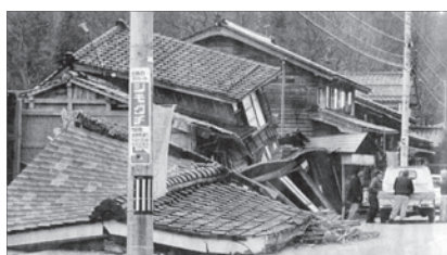
（写真2）家屋の倒壊
